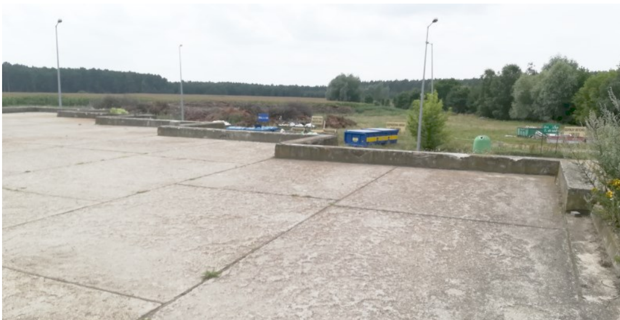
Ryc. 6. Powierzchnia rampy rozładunkowej, krawędź rampy przewidziana do przebudowy poprzez uzupełnienie konstrukcji oraz montaż barierek
