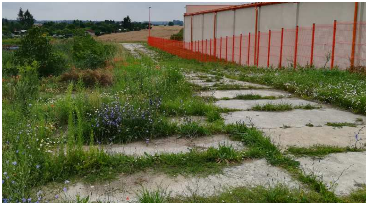
Ryc. 3. Dojazd do PSZOK – w ramach przedsięwzięcia należy wyrównać podbudowę płyt betonowych oraz poprawić ich ułożenie niwelując obecnie występujące uskoki i nierówności podłużne i poprzeczne
