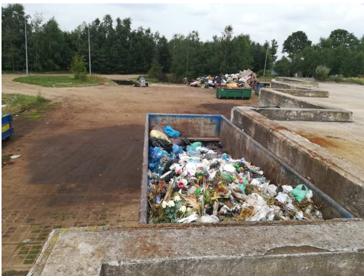
Ryc. 7. Po prawej - rampa rozładunkowa, krawędź rampy przewidziana do przebudowy poprzez uzupełnienie konstrukcji oraz montaż barierek, po lewej plac odbioru kontenerów, obszar magazynowania kontenerów przewidziany do przebudowy i skanalizowania do planowanego zbiornika ścieków przemysłowych
